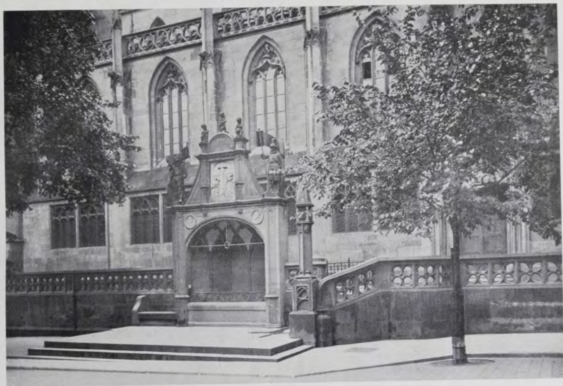
Der Kirchbrunnen vor der Kilianskirche vor der Zerstörung am 4. Dezember 1944
